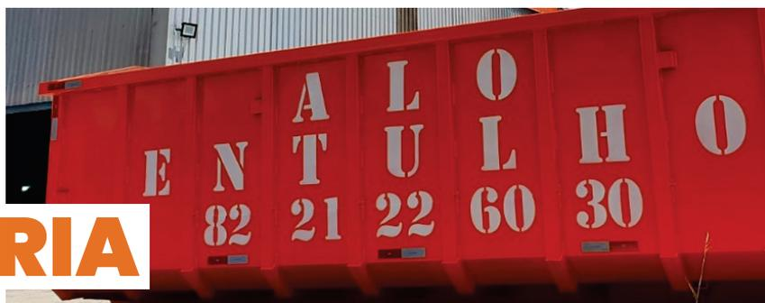
Caçamba estacionária é apropriada para depósito de resíduos de construção civil para posterior descarte, assim como contêineres. A principal diferença é a capacidade para 18m<sup>3</sup> e 28m<sup>3</sup>, ideal para grandes obras ou demolição.
